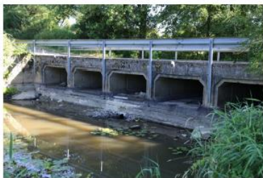
Pont seuil comprenant cinq cadres actuellement. Le projet prévoit une ouverture dans la partie centrale
